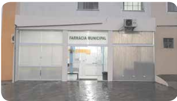
Figura 4: Fachada remodelada com a troca dos portões de ferro por vidros e colocação de cortinas.
