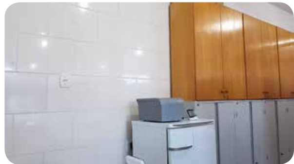
Figura 5: Parede com revestimento cerâmico para evitar o acúmulo de mofo e facilitar a limpeza.
